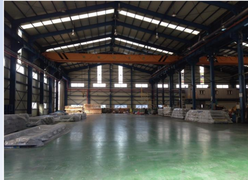
조립 공장 (50m x 20m, 303평)
